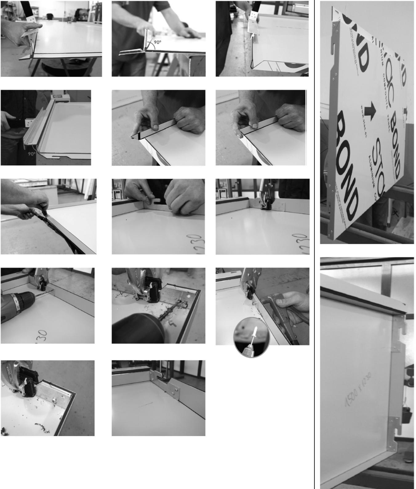
Figure 2b – Façonnage des cassettes (Usinage/Assemblage)
