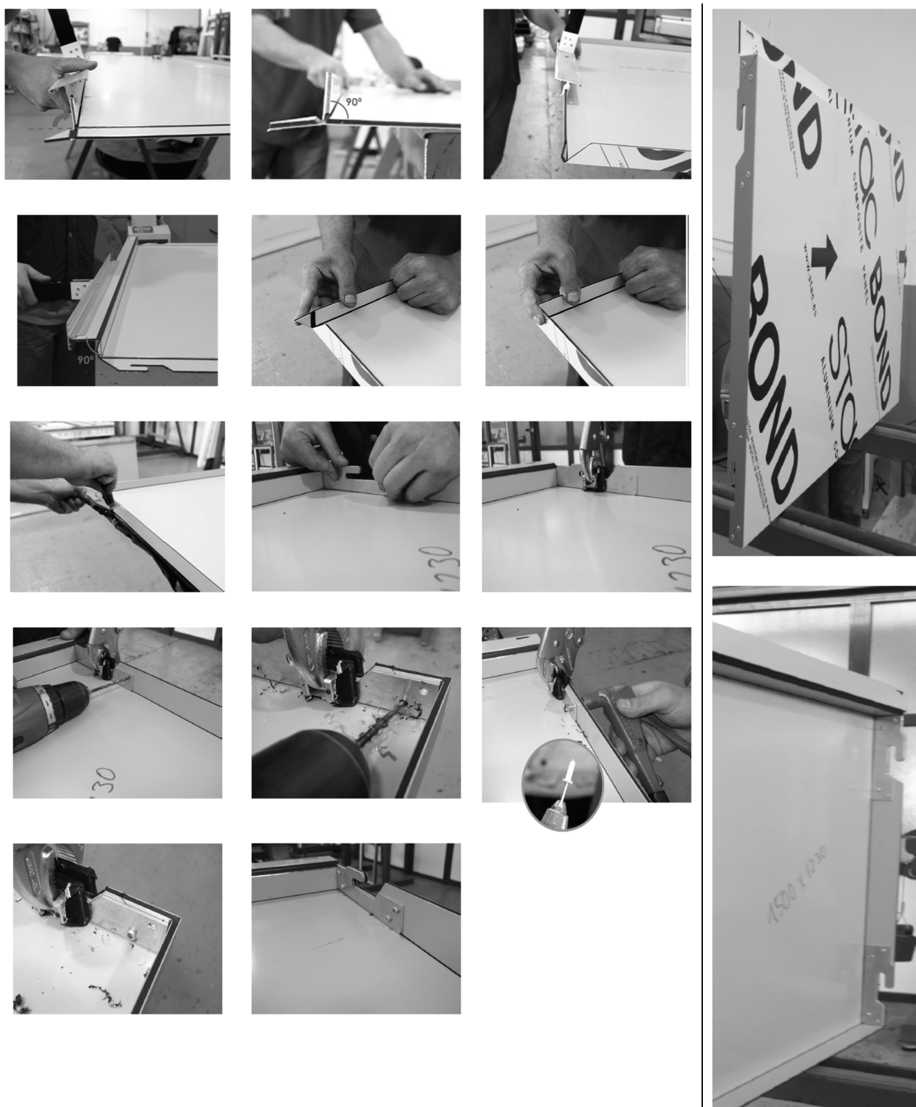
Figure 2b – Façonnage des cassettes (Usinage/Assemblage)
